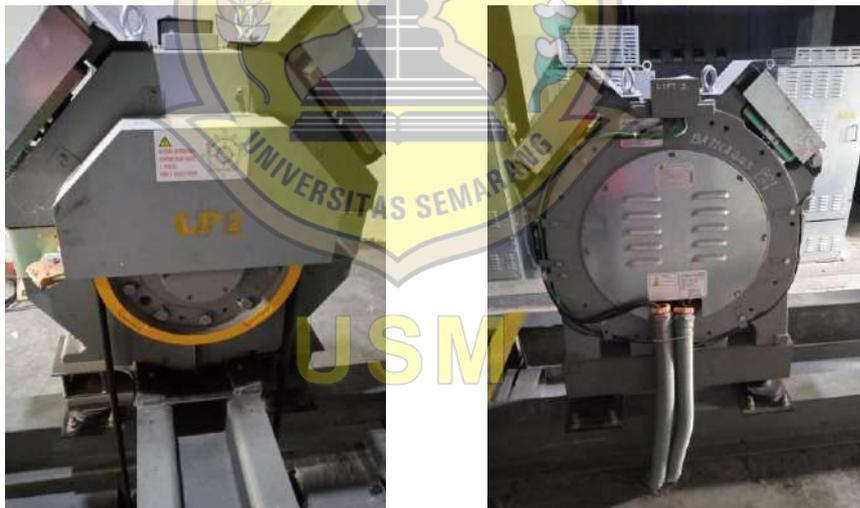
Gambar 3.3. Motor induksi tiga fasa penggerak elevator
