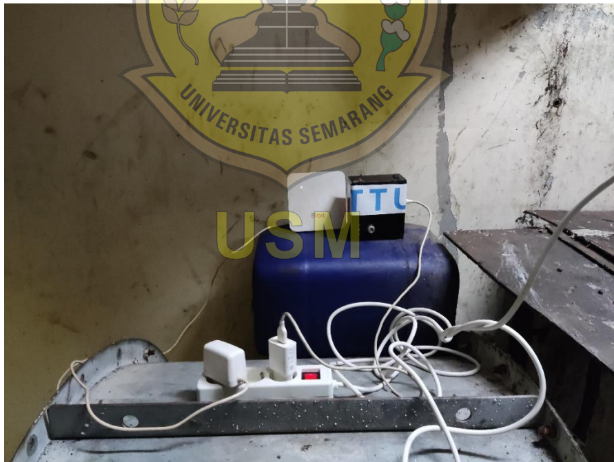
Gambar 4.3 Dokumentasi Penempatan Alat di Lokasi Basement
